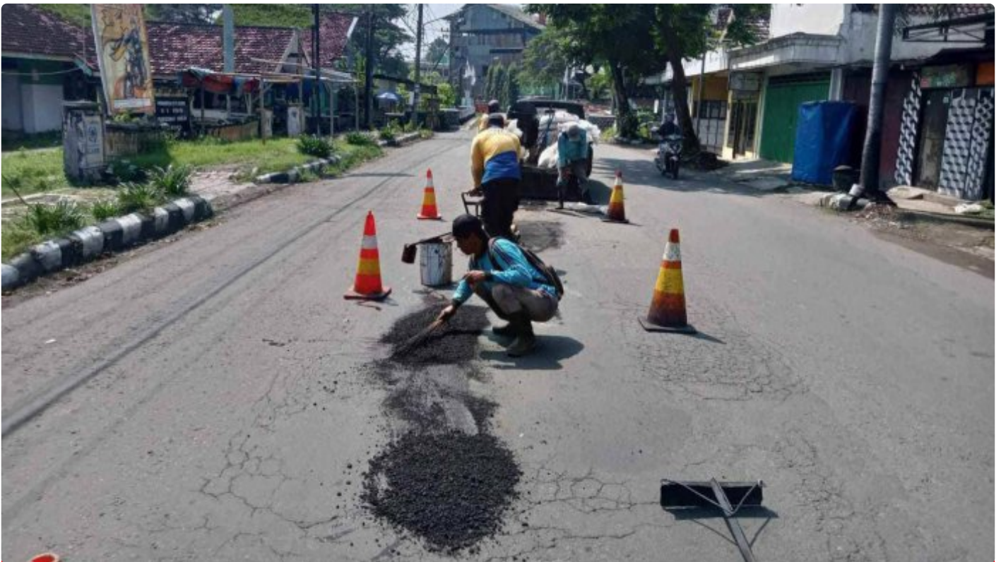
Dinas PUPR Kota Kediri menambal jalan berlubang di sepanjang Jalan Merbabu Mrican
